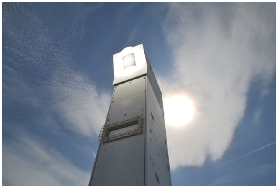
Ilustración 13 Cuadro de apunte o target bajo receptor en torre concentradora experimental en Jülich. Fuente: DLR
