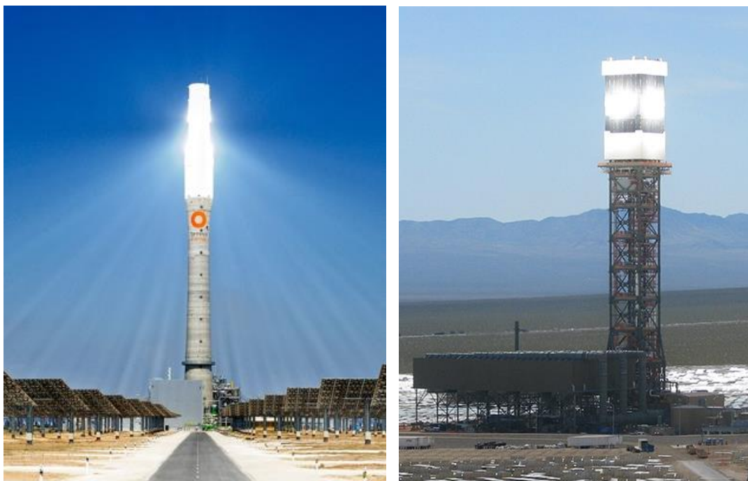
Ilustración 14 A la izquierda: Torre de concreto de planta Gema Solar en España. A la derecha: Torre de estructura metálica de planta Ivanpah en Estados Unidos.
